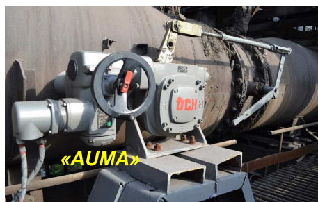
Регулирующий дроссель на трубопроводе доменного газа
