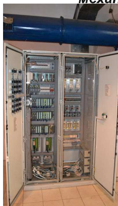
ШУ общестанционными механизмами
